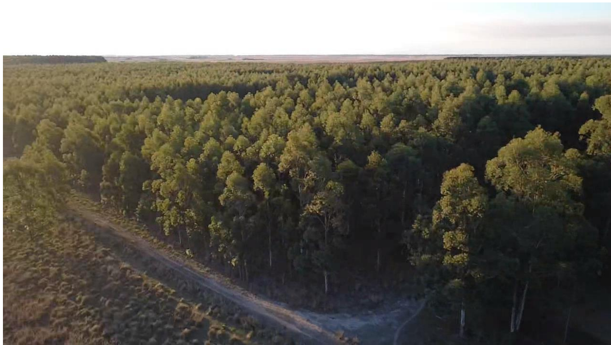
Vista aérea oblicua de rodales y camino interno.
